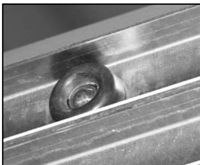
Рис. 39. Установка ограничителя хода полотна
