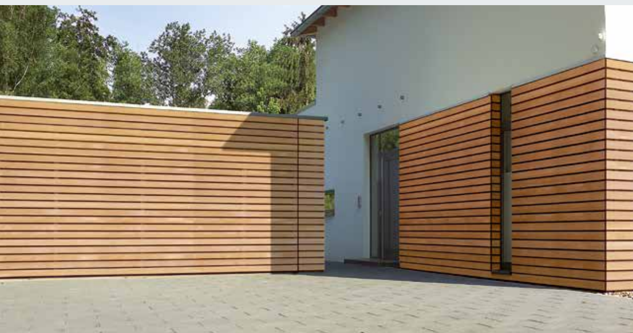
Облицовка деревянными панелями, выполняемая заказчиком
